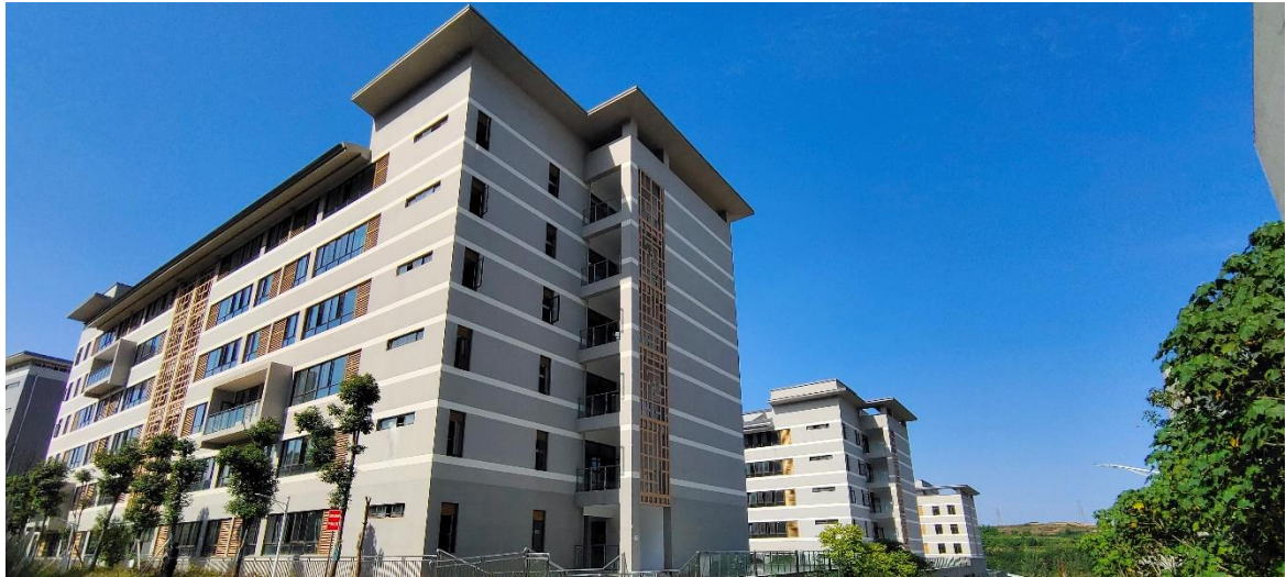
2022年10月16日，二期工程建设项目一、二、三号教学楼（侧面）
